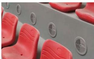
为了改善观众的舒适度和空气流通性，体育馆观众区采用座椅送风。送风系统通过安装在体育馆看台座椅周围的通风口或送风口，将新鲜空气输送到观众席位上。
