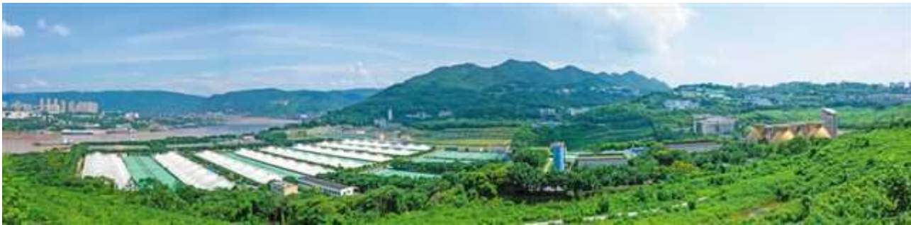
鸡冠石污水处理厂
