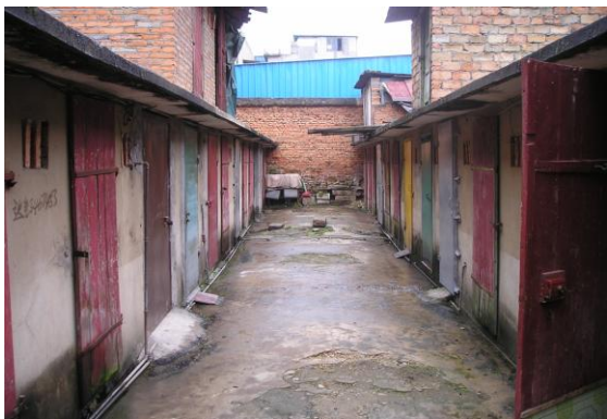
复园小区建杂物间原河道改 d600
