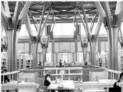
图 1 美国比弗顿图书馆树形支撑 Fig. 1 Tree-like support of Beaverton library in USA
