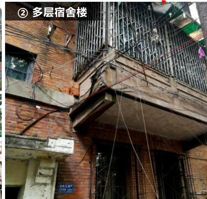
②现状多层（宿舍楼） — 结构安全度：结构存在很大安全隐患；层数：三至五层；外立面状况：外立面破损严重。
