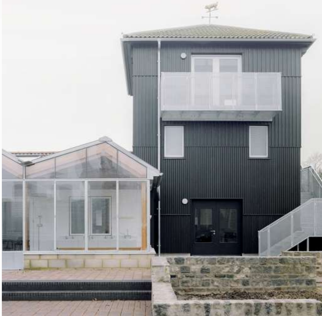
新建建筑与既有的三层建筑
