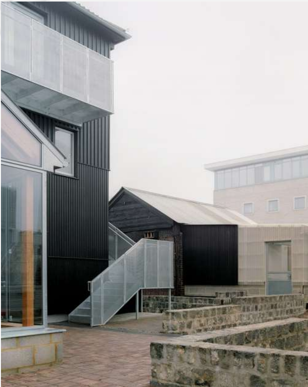
建筑选用带有隔热层的外部饰面和高性能的门窗
